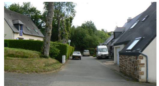
Front urbain discontinu, avec jeu de retrait/alignement qui ménage des places de stationnement (Plaintel)
