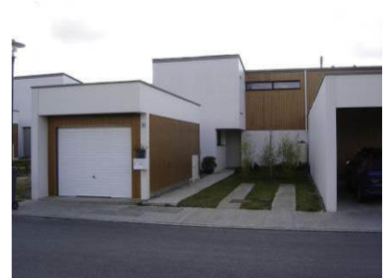
Volume principal en retrait, garage à l'alignement (Acigné)
