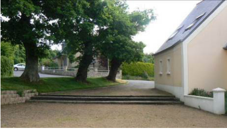
Construction à l'alignement d'une place (Plaintel)
